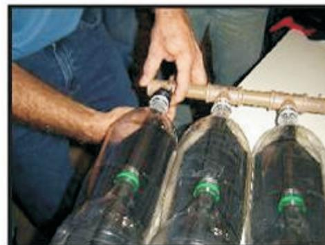
Você também pode substituir a fita de alto fusão por tiras de borracha (ex: câmaras de ar), sem perda de eficiência. Esse material evita a fuga de calor do interior da coluna e impede que o vento gire as garrafas, tirando as embalagens longa vida pós-consumo da posição voltada para o Sol, comprometendo o rendimento do coletor solar.
